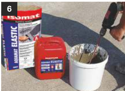
6 Παρασκευάζεται το AQUAMAT-ELASTIC , με ανάμιξη του Α-συστατικού (κονία) στο Β-συστατικό (ελαστικοποιητής) και το απαιτούμενο νερό. Εναλλακτικά μπορεί να χρησιμοποιηθεί το ετοιμόχρηστο ISOFLEX-PU 500 .
