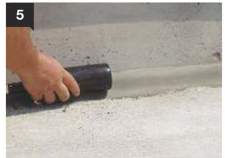
5 Τέλος λειαίνεται με τη βοήθεια κυλινδρικού αντικειμένου (π.χ. μπουκάλι), ώστε να διαμορφωθεί καμπύλο λούκι.
