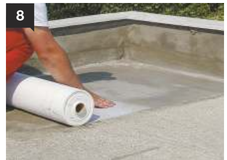
8 Στη νωπή στρώση του AQUAMAT-ELASTIC , τοποθετείται και ενσωματώνεται πολυεστερικό ύφασμα ( TREVIRA ) πλάτους 1 m.
