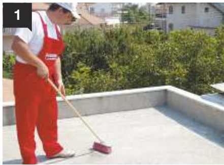
1 Αρχικά καθαρίζεται καλά το υπόστρωμα από σκόνες, σαθρά υλικά κτλ.
