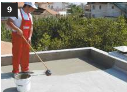
9 Η ενισχυμένη με πολυεστερικό ύφασμα πρώτη στρώση, αφού στεγνώσει, καλύπτεται από μία δεύτερη επάλειψη με AQUAMAT-ELASTIC .
