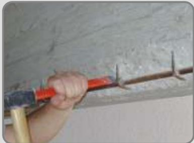
Mehaničkim putem uklanjamo sve trošne delove betona, nastojeći da u potpunosti otkrijemo korodiranu armaturu.
