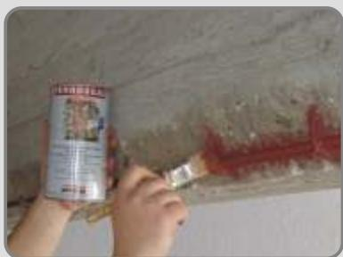
Očišćena armatura se premazuje sa **FERROSEAL** u dva premaza. Materijal se meša samo sa vodom.
