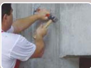
Prvo se mehaničkim putem uklanjuju sva trošna ispuštenja sa površine betona.
