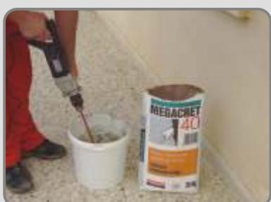
Reparacija betona se vrši vlaknima ojačanim cementnim malterom **MEGACRET-40**. Materijal se meša samo sa vodom.
