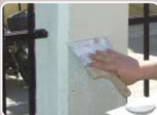
Materijal se nanosi špahtlom, u jednom ili dva sloja, zavisno od nepravilnosti površine. Drugi sloj se nanosi tek po sušenju prvog.
