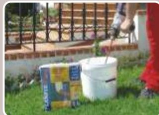
U vodu se dodaje cementni prah, uz stalno mešanje, dok se ne formira homogena pasta pogodna za nanošenje špahtlom.
