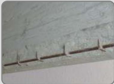
Korozija armature prouzrokuje otpadanje delova betona, što dovodi u opasnost čitavu građevinu.
