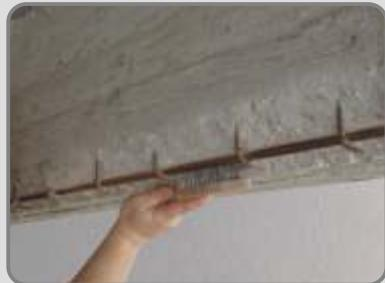
Sa armature mehaničkim putem (pomoću žičane četke) u potpunosti skidamo koroziju.
